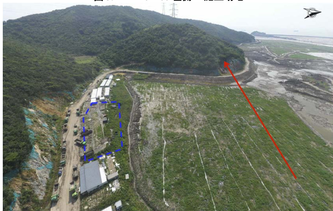
图 3.4-2 K1+800 左侧 2#施工场地
