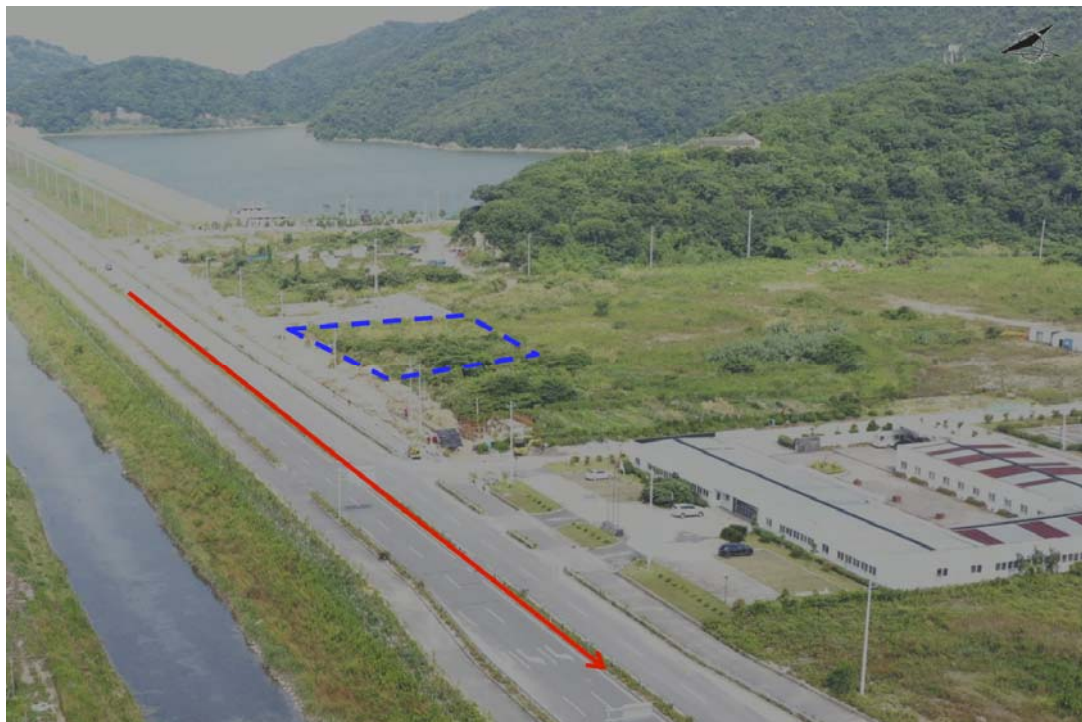
图 3.4-1 K0+200 左侧 1#施工场地
